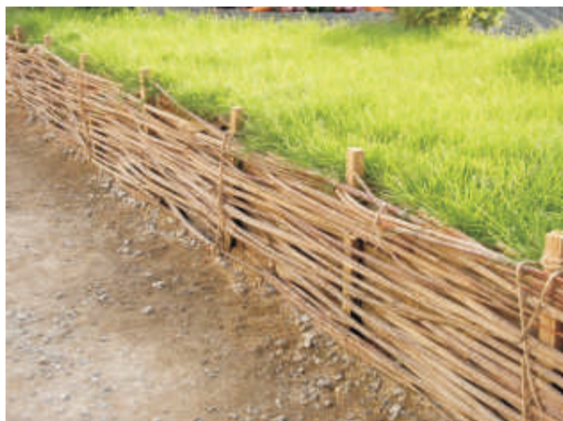
stěny z proutí
